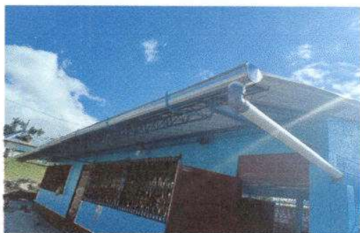
Foto 5: Sustitución de canal de pvc por canal de metal en módulos 1 y 2
