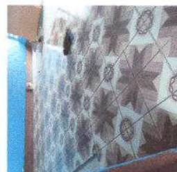
Foto 4: Sustitución de piso de torta de concreto por piso cerámico en módulo 2
